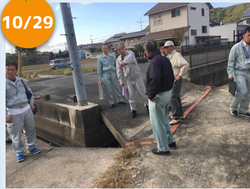
西日本豪雨 現地調査
